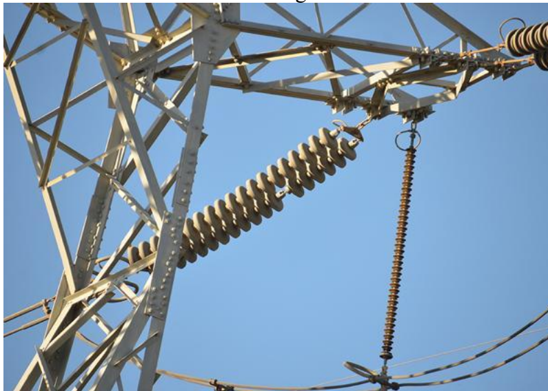
1. ábra: Szabadvezetéki szigetelő használat közben
